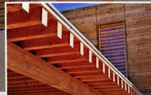
"Il s'agit d'une cave viticole privée composée d'une cuverie, d'un chai, d'une zone de stockage, d'un accueil pour le public et d'un logement de fonction. Ce bâtiment au volume cubique s'insère dans le paysage grâce au bardage bois. L'ossature bois repose sur une dalle béton et sur des murs monomur pour les zones semi enterrées. Le bâtiment accueille cette année ses premières vendanges."
